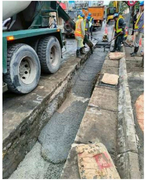
圖 6 焚化再生粒料用於管溝回填
